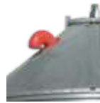
Respiradero en el techo para evitar el incremento de humedad dentro del silo.
